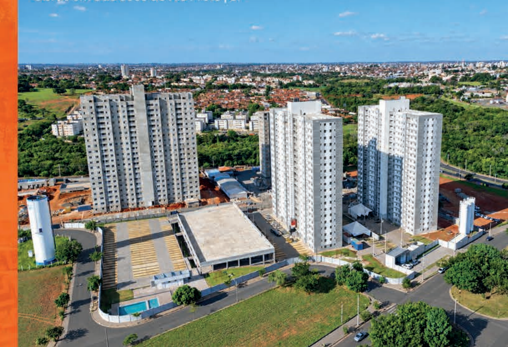
Obras em São José do Rio Preto | SP
